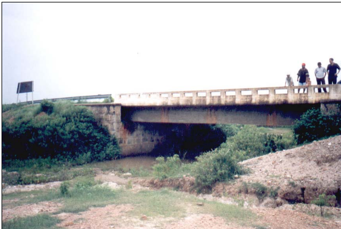
FOTO 02: Ponte da BR-226, sobre o riacho Cipó. Notar as vigas de apoio do tabuleiro e o encontro na margem esquerda. Essa ponte pode limitar a cota do nível da água do reservatório. Caso não seja alteada (10/04/02).
