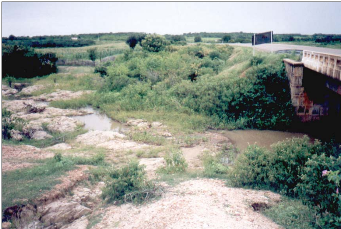
FOTO 01: Riacho Cipó, imediatamente a montante de ponte de concreto da rodovia BR-226. Notar os afloramentos de gnaiss alterado duro, em xistosidade sub-horizantal (5° a 10° de mergulho) e aterro de encontro na margem esquerda (10/04/02).
