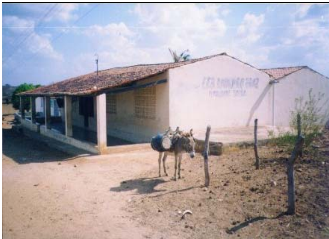
FOTO 12: Cisterna da Barra do Cipó (detalhe do jumento utilizado para transporte d'água)
