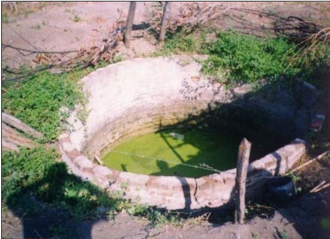
FOTO 16: Cacimão (poço amazonas) de Cipó
