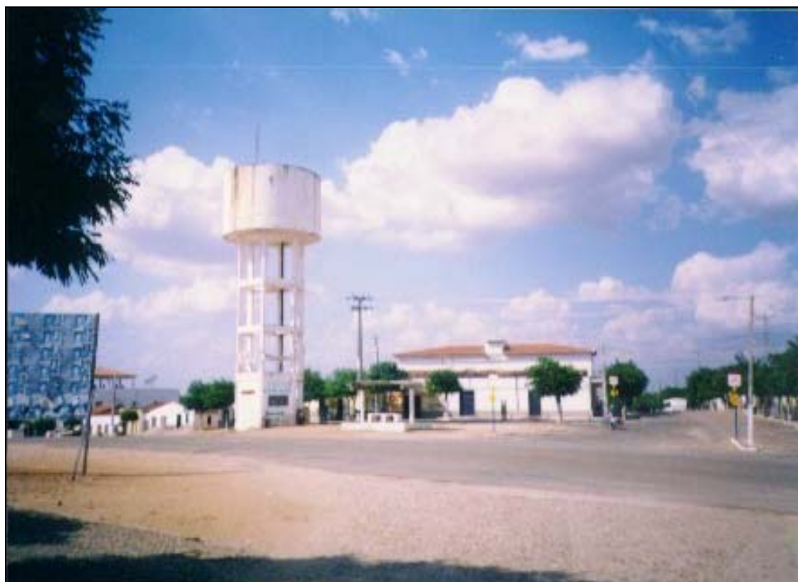
FOTO 14: Reservatório Elevado de Milhã
