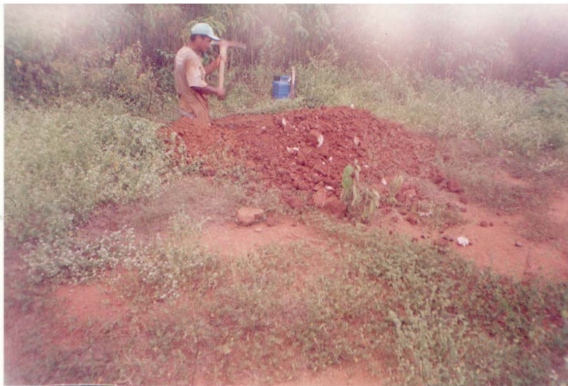
FOTO 24: Escavação de furos de sondagens na área da jazida J-02, efetuados por ocasião da execução dos estudos geotécnicos.
